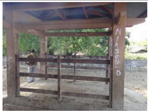
Kondisi lokasi timbangan di Pasar Hewan Kab. Kupang
